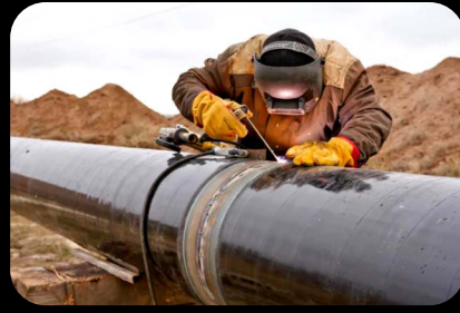
WELDING - MIG & MAG
